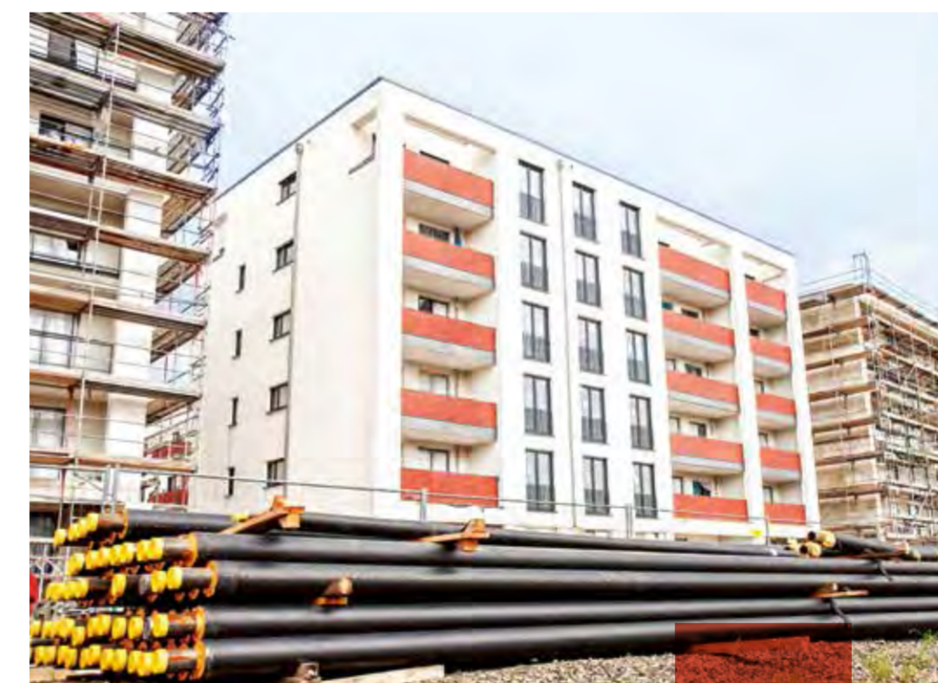
Die Rohrleitungen liegen bereit: Die RheinEnergie versorgt das neue Quartier künftig mit klimaschonender Fernwärme.
