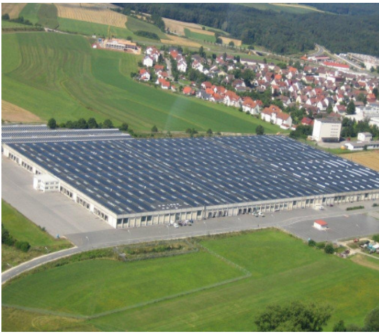
Solaranlage der SILAG Objekt Sonnefeld GmbH auf 73.000 qm Dachfläche
